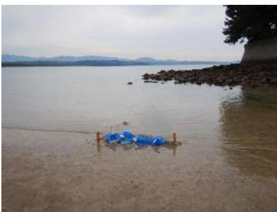
地点E 設置
