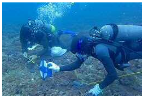
図-8 潜水作業の様子
